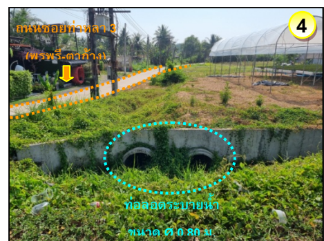
ท่อระบายน้ำตามแนวถนนซอยท่าหลา 3 (พรพรี-ตากัง) จำนวน 2 ท่อ ขนาด Ø 0.80 ม.
