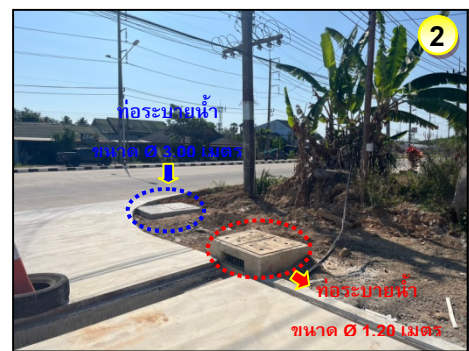
ท่อระบายน้ำสาธารณะ ขนาด Ø 3.00 เมตร ตามแนว ทางหลวงแผ่นดินสายสี่แยกท่าเรือ-เมืองใหม่ (4027)
