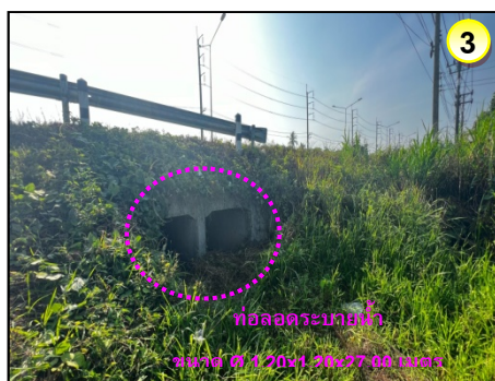
ท่อลอดใต้แนวทางหลวงแผ่นดินสาย สี่แยกท่าเรือ-เมืองใหม่ (4027) จำนวน 2 ท่อ ขนาด Ø 1.20x1.20x27.00 เมตร
